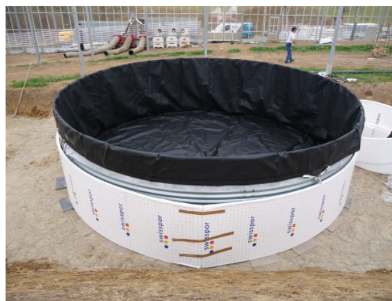
Рыбоводный бассейн в стадии строительства (Фотография: IEES)
