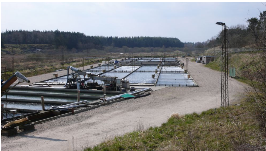
Опытное форелевое хозяйство (Айstrupхольм Дамбруе): На заднем плане слева видны водоочистные пруды с растениями, состоящие из бывших земляных прудов, водоподающих и водосливных каналов (Фотография: DTU-Aqua)
