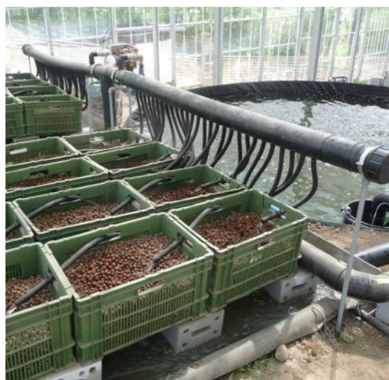
Аквакультурный модуль в стадии строительства (Фотография: IEES)
